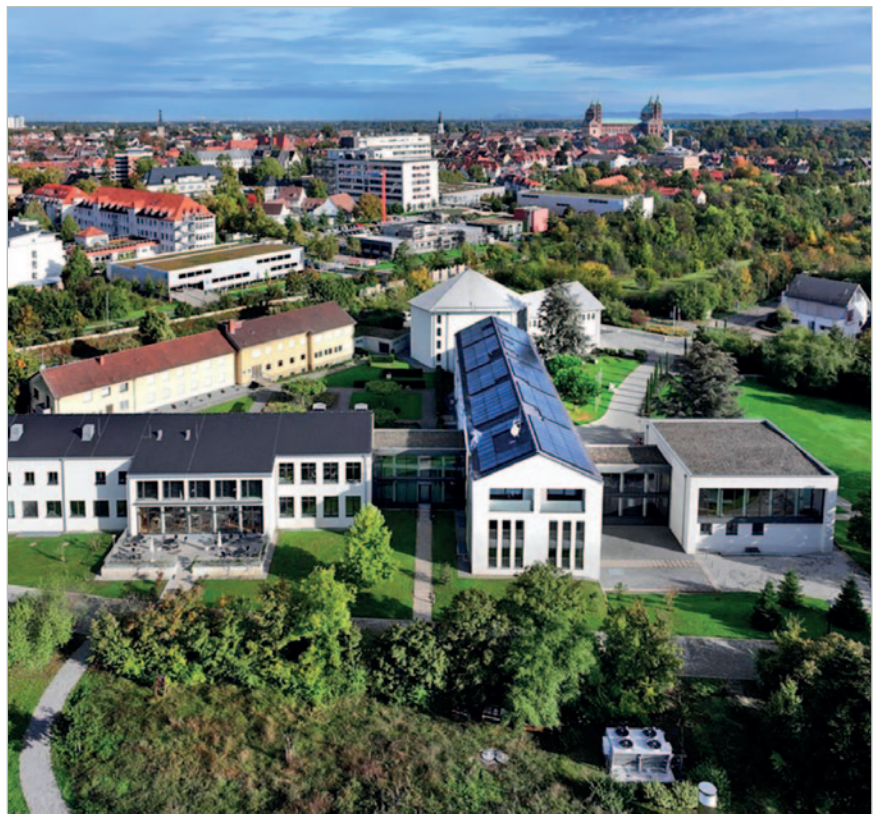
Die Photovoltaikanlage (Foto: K. Landry)
